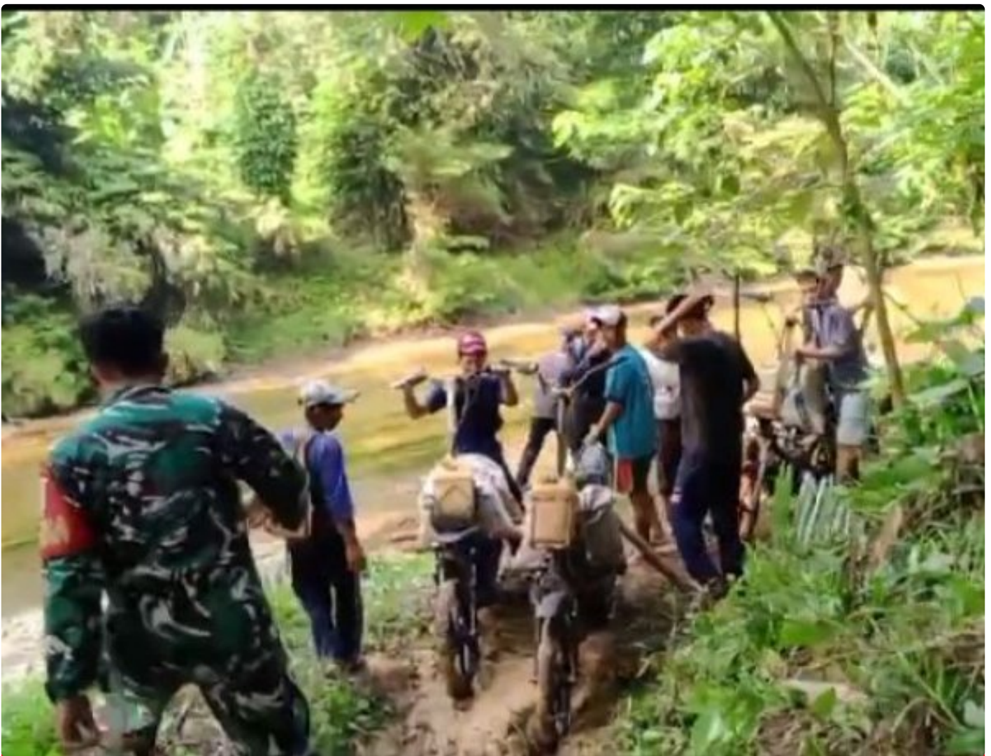
pengambilan material pasir dan batu untuk pondasi jembatan
